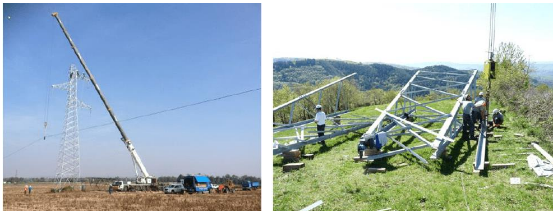
Figure 9 : Exemple de dépose d'un pylône électrique
