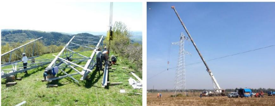
Figure 8 : Exemple de mise en place de nouveaux supports
