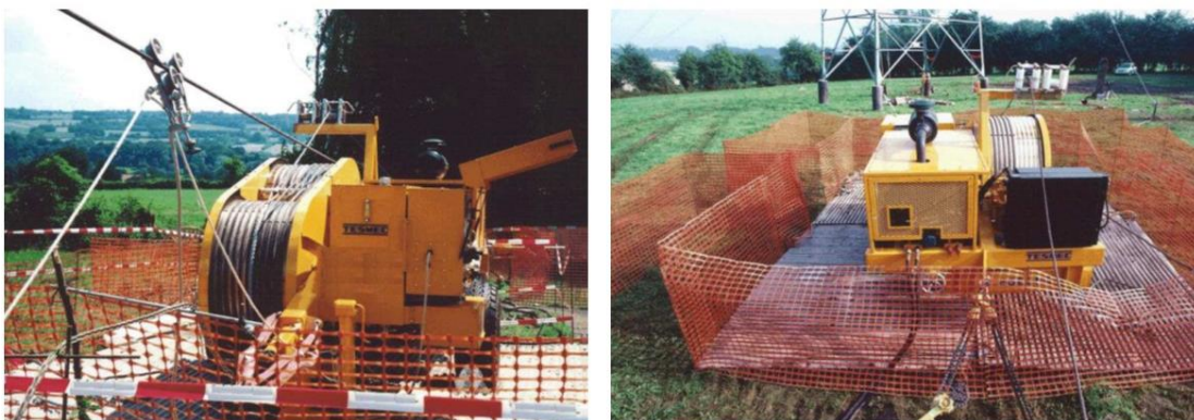
Figure 6 : Exemple de plateformes de déroulage (Source : RTE)
