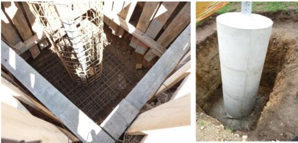
Figure 7 : Exemple de réalisation de nouvelles fondations
